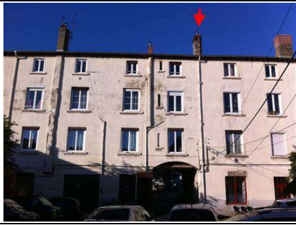
Photo n° PhA002 Localisation : Enveloppe extérieure bâtiments Ouvrage : Conduits en toiture et façade Partie d'ouvrage : Conduits de fumée en amiante-ciment Description : Mitron en amiante-ciment (niveau toiture bâtiment)
